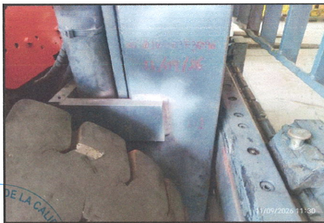
APLICACIÓN DE REVELADOR A ZONA DE INSPECCIÓN
