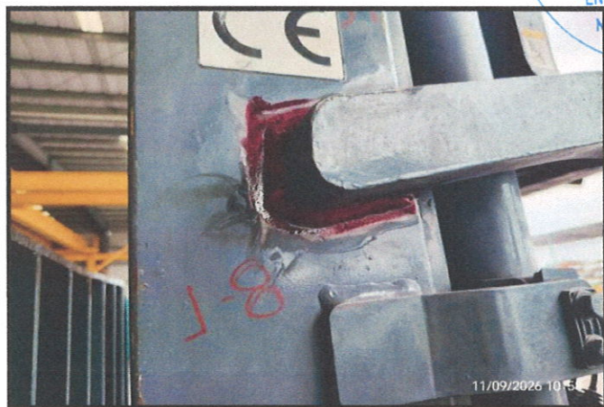
APLICACIÓN DE PENETRANTE A ZONA DE INSPECCIÓN
