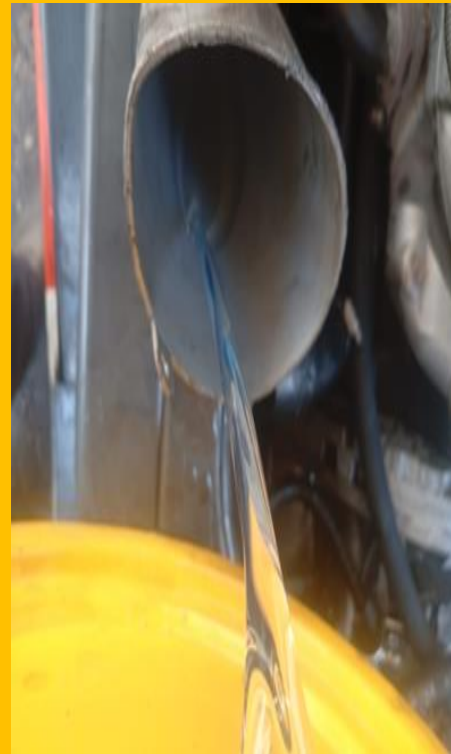
REEMPLAZO DE ACEITE HIDRÁULICO
