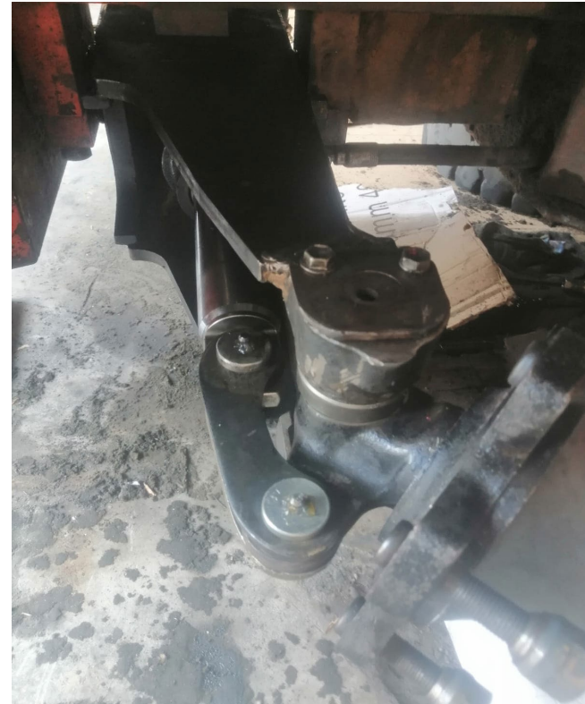
EJE DE DIRECCION ARMADO E INSTALADO LADO IZQUIERDO
