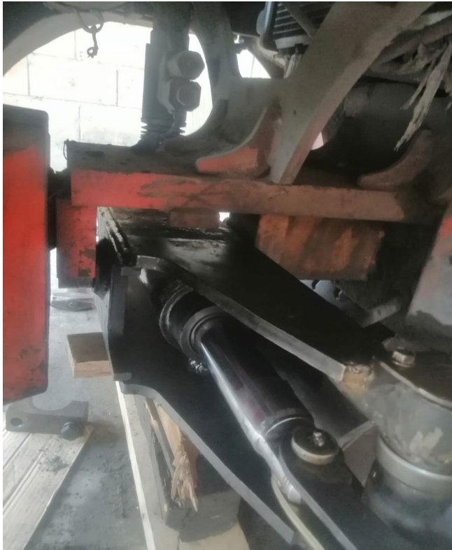
EJE DE DIRECCION ARMADO E INSTALADO LADO DERECHO
