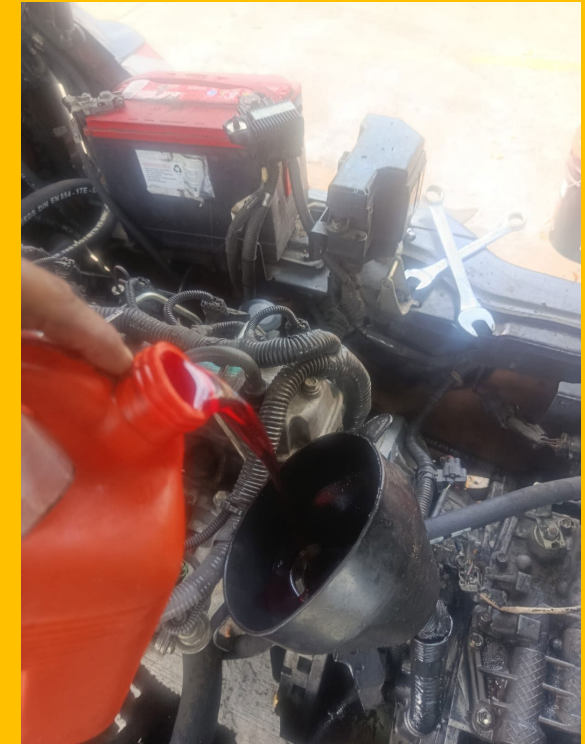
REEMPLAZO DE ACEITE DE TRANSMISION
