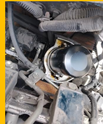
FILTRO ACEITE DE TRASMISION INSTALADO
