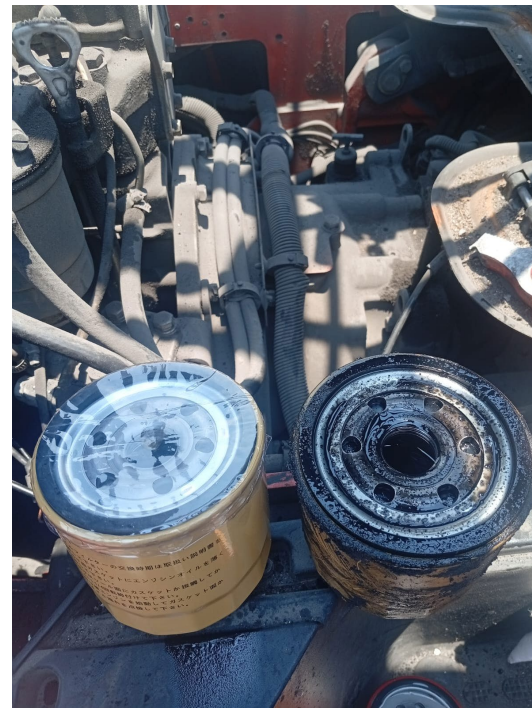
REEMPLAZO DE FILTRO DE ACEITE HIDRAULICO
