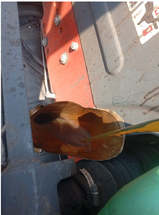
REEMPLAZO DE ACEITE HIDRAULICO
