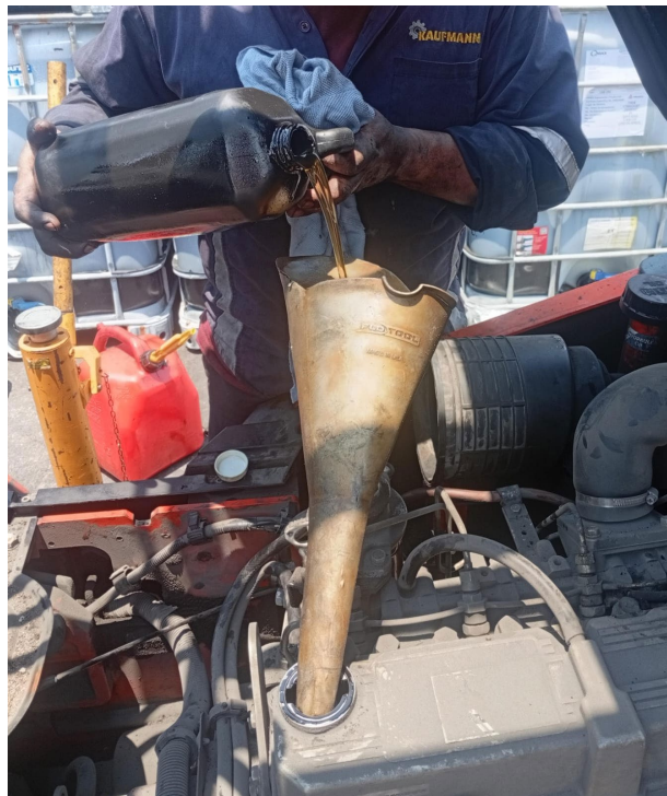
REEMPLAZO DE ACEITE DE MOTOR
