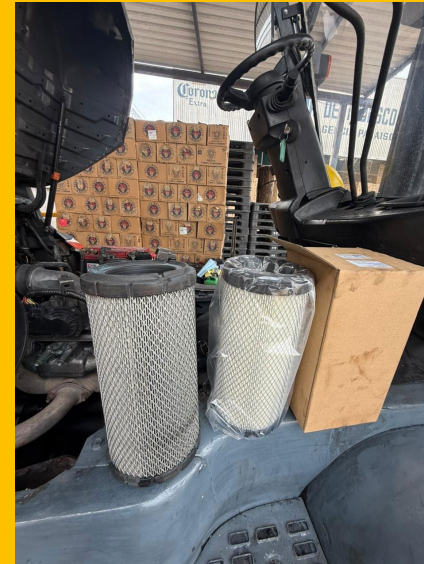
REEMPLAZO DE FILTRO DE AIRE
