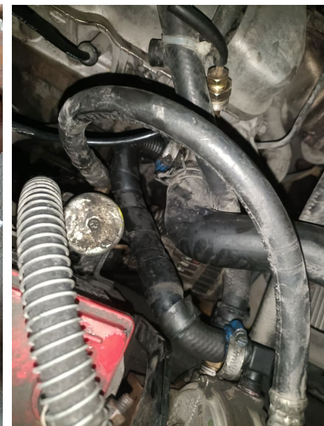
MANGUERA INSTALADA Y FUGA REPARADA.
