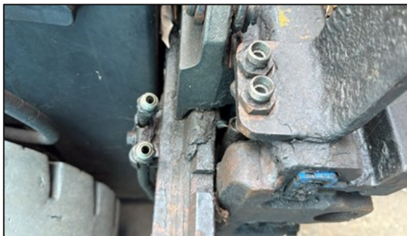
NO CUENTA CON MANGUERAS PARA DESPLAZADOR
