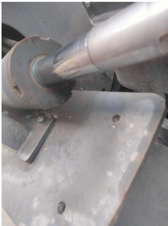
FUGA EN CILINDRO DE GATO DE INCLINACIÓN DERECHO (SELLOS)
