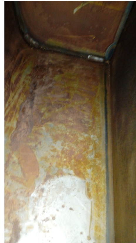
LIMPIEZA DE TANQUE
