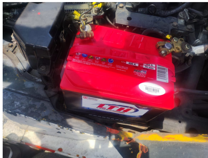
BATERÍA NUEVA INSTALADA
